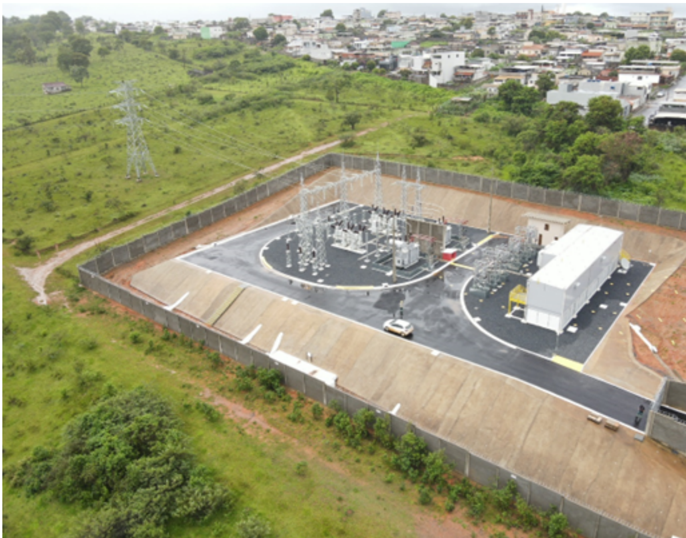
Figura 4 – SE Híbrida com 2 linhas e 2 Transformadores
